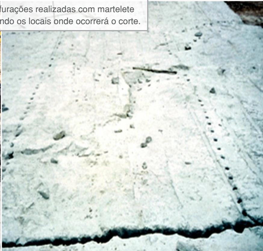
Extração de blocos por meio de marteleto pneumático.
