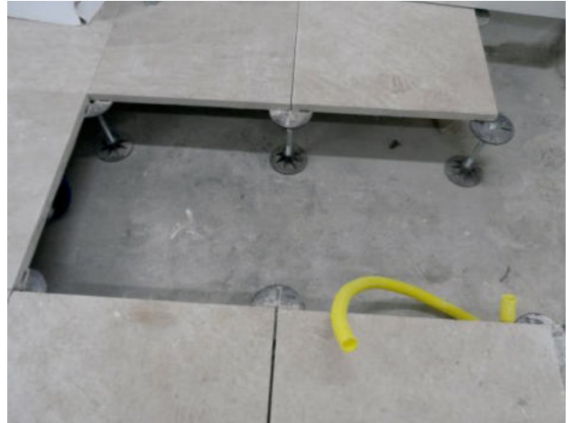
Ilustração de montagem de piso elevado, com placas de rocha (Foto: Eleno de Paula Rodrigues).
