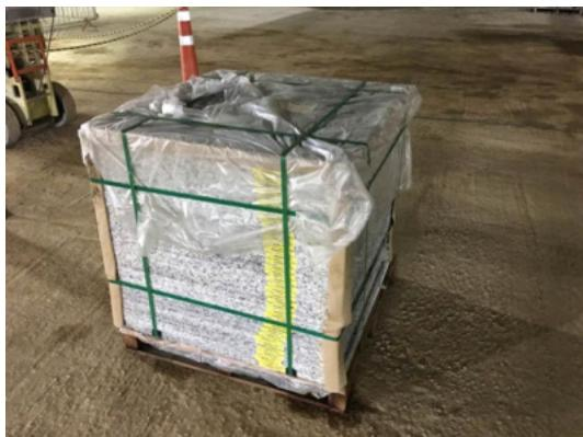
**Foto 35** - Exemplo de embalagem mal feita, na qual apenas parte das peças rochosas encontra-se protegida com lona plástica e a rocha mantém contato direto com papelões e madeira. Risco de manchamento.
