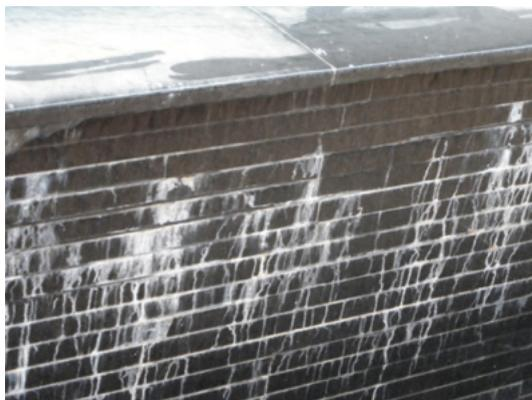
**Foto 7** - Ocorrência de eflorescência em granito preto em parede de espelho d'água. Os sais esbranquiçados provêm do rejuntamento entre as peças.
