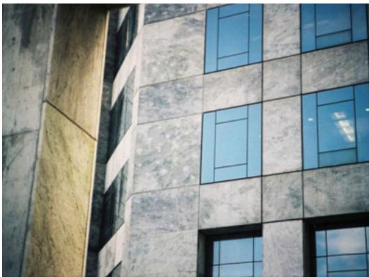
**Foto 29** - “Manchas” brancas (áreas arredondadas, “impermeabilizadas” pelo produto de silicone acético aplicado no tardo) em granito cinza (escurecido por umidade), após longo período de chuvas.
