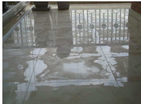
**Foto 4** - Exemplo de piso em mármore, com patologia de enturvação superficial causada por umidade ascendente.
