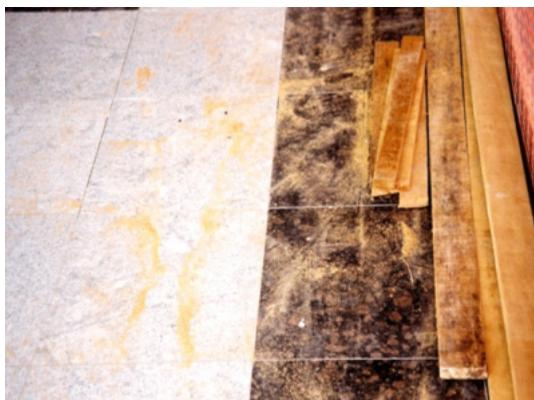
**Foto 11** - Restos de madeira e pó de madeira sobre piso de granito (risco de manchamento se ocorrer contato com água).
