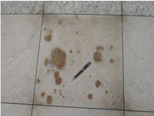
**Foto 16** - Manchamentos provocados pela oxidação do mineral pirita ( $\text{FeS}_2$ ), presente originalmente no granito.
