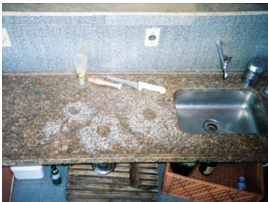
**Foto 20** - Corrosão química provocada pelo contato de ácido cítrico (presente no limão) e o granito.
