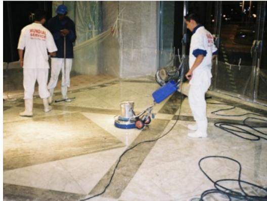
**Foto 22** - Equipamento tipo “enceradeira” utilizado no repolimento de rochas corroídas quimicamente.
