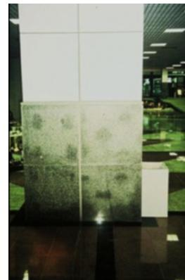
**Foto 30** - Manchas escuras arredondadas, provocadas pela “massa plástica” (contendo catalizador em quantidade insuficiente) aplicada no tardo do granito.
