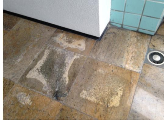
**Foto 2** - Exemplo de piso em granito, com patologia de escamação superficial causada por umidade ascendente.
