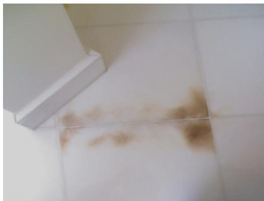
**Foto 12** - Manchas provocadas pelo contato do piso, em mármore branco, com pó de madeira.
