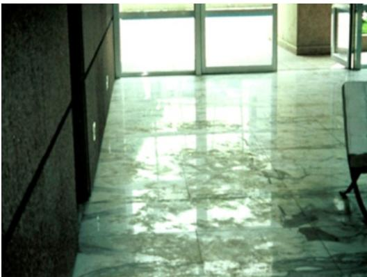
**Foto 3** - Exemplo de piso em mármore, com patologia de enturvação superficial causada por umidade ascendente.
