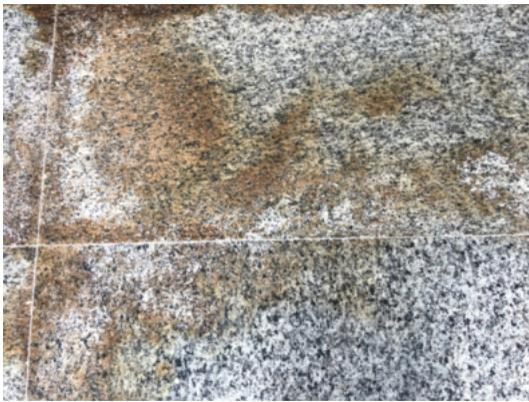
**Foto 14** - Manchamentos provocados pelo contato do granito com palha de aço que oxidou e liberou pigmentos amarelados.
