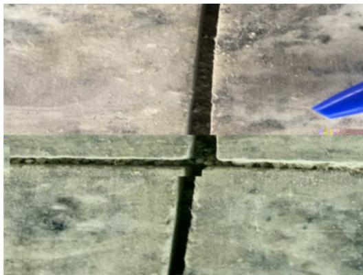
**Foto 34** - Peças de granito mostrando variações dimensionais e cantos não ortogonais, provocados pelo corte incorreto das chapas.
