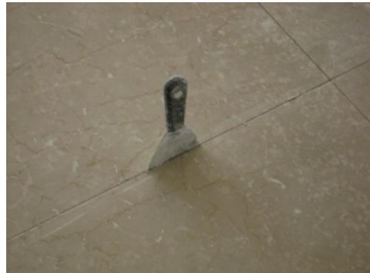
**Foto 10** - Espátula de ferro sendo utilizada para limpar juntas ainda abertas. Com essa prática, a espátula será friccionada contra as bordas das juntas e liberará pó de ferro que, com umidade, provocará manchamento amarelo na rocha.
