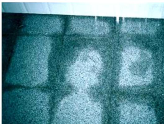
**Foto 19** - Peças de granito assentadas em piso, mostrando forte escurecimento por umidade, nas adjacências das juntas.
