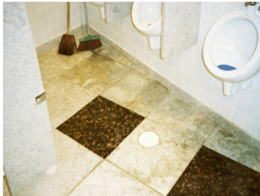
Foto 24 - Manchamento provocado pelo contato de granitos com urina.
