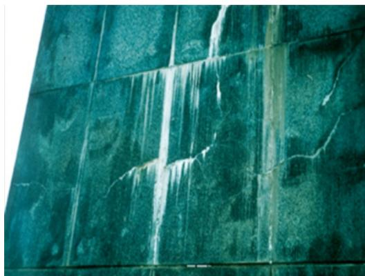
**Foto 6** - Ocorrência de eflorescência (crostas esbranquiçadas) sobre peças de granito fixadas em fachada com argamassa.
