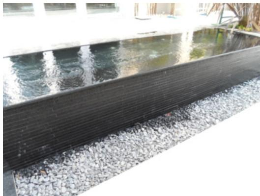
**Foto 8** - Mesmo local mostrado na foto anterior, após tratamento químico e substituição do rejunte cimentício por rejunte epóxi.
