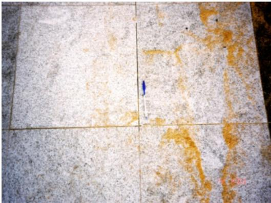
**Foto 9** - Pó de madeira sobre peças de granito ainda não rejuntadas. O pó que penetra nas juntas abertas provocará, em presença de umidade, manchamento amarelo na rocha.
