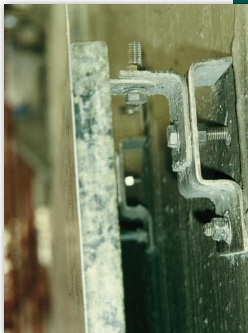
**Foto 44** - Detalhe de inserto metálico em fachada ventilada utilizando placa de granito.
