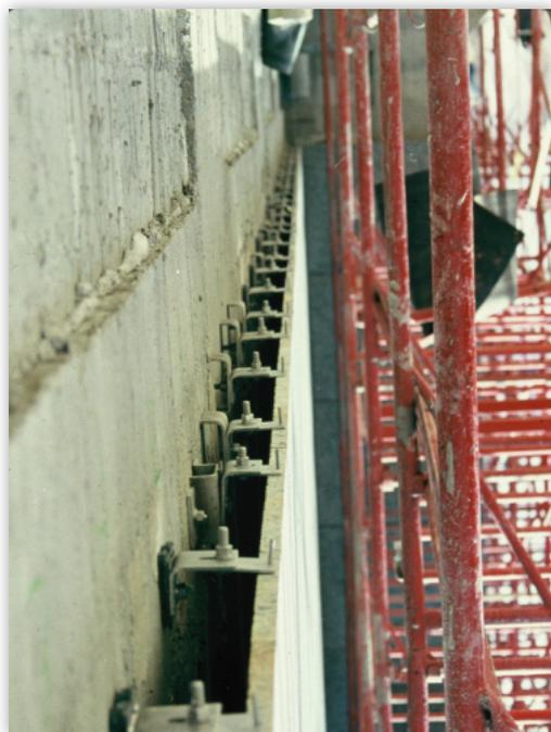
**Foto 43** - Vista parcial de fachada ventilada utilizando placas de granito. Notar insertos metálicos alinhados.
