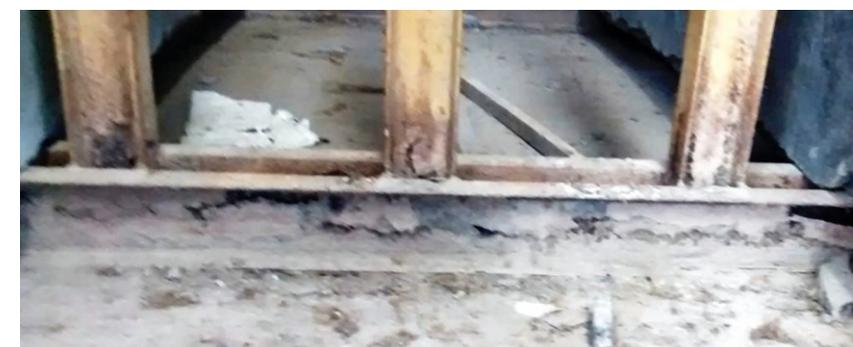
Figura 8 - Base de cavalete vertical deteriorada e sem condições de uso.
