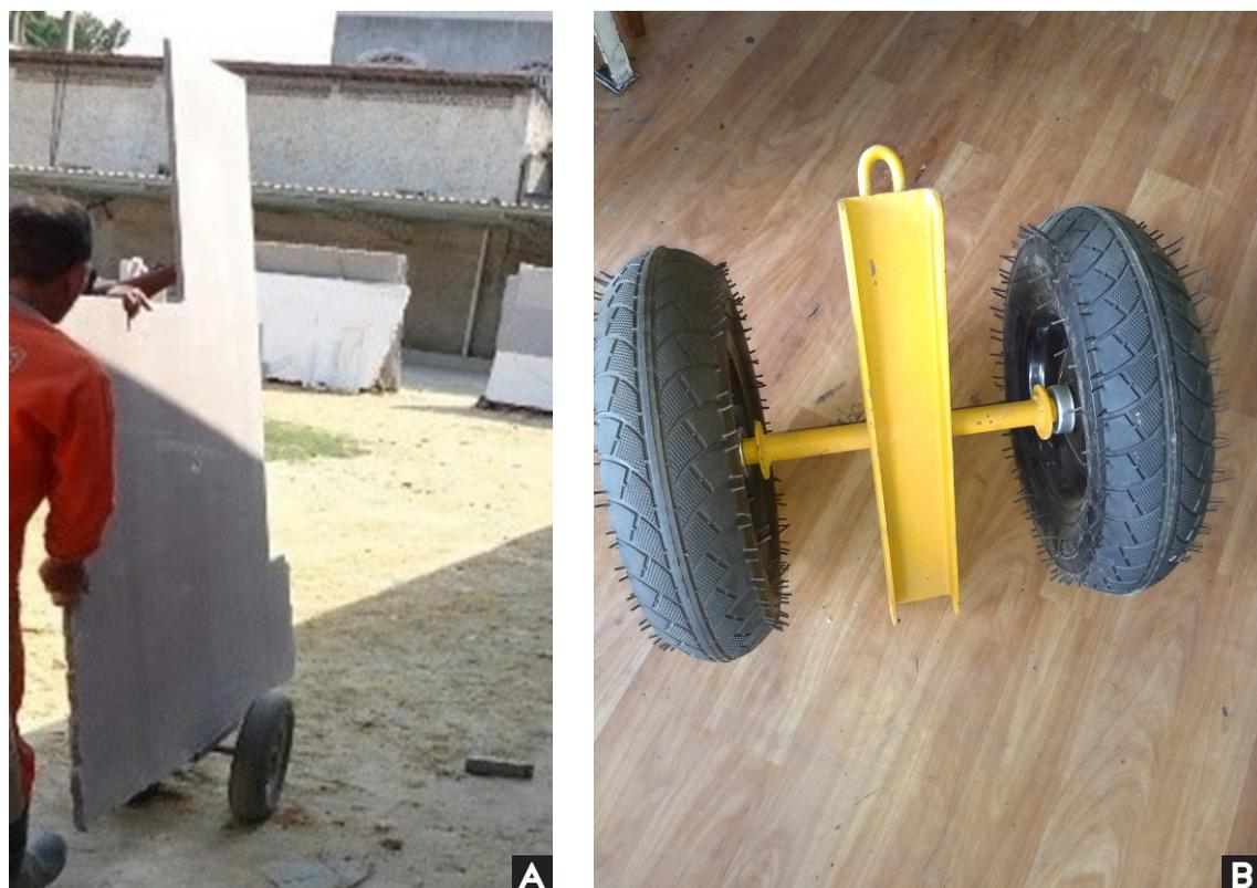
Figura 5 - Observe que o equipamento do tipo “mulinha” não oferece apoio estável e adequado para as peças transportadas.
