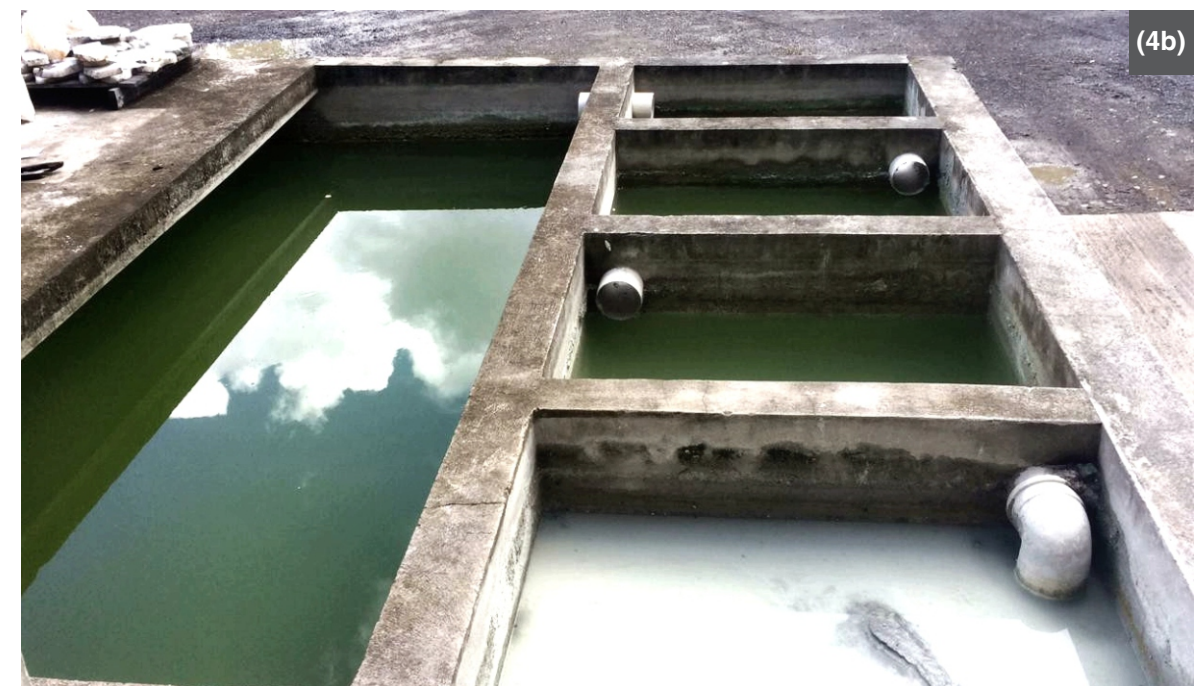
Figura 4 - Exemplo de tratamento do efluente resultante do beneficiamento de rochas ornamentais: (a) e (b) sistemas de decantação de lama abrasiva. (Foto (a): Jéssica G. Mathielo; Foto (b): Álvaro Cintra Jr.)
